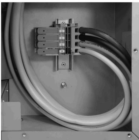
Fig. 25: Bornes présentes dans le boîtier de raccordement
